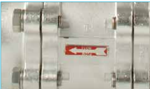
Указатель направления среды на корпусе
